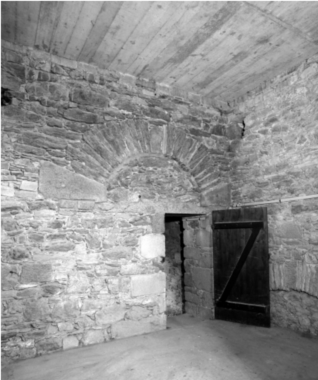
Intérieur, deuxième niveau, bas-coté, porte : vue générale
