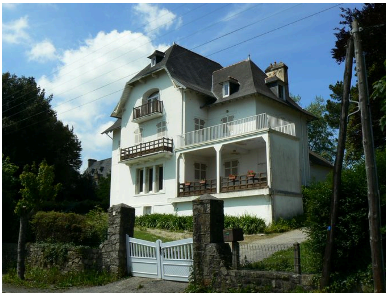
Vue générale de la villa Ker An Eol, côté mer
