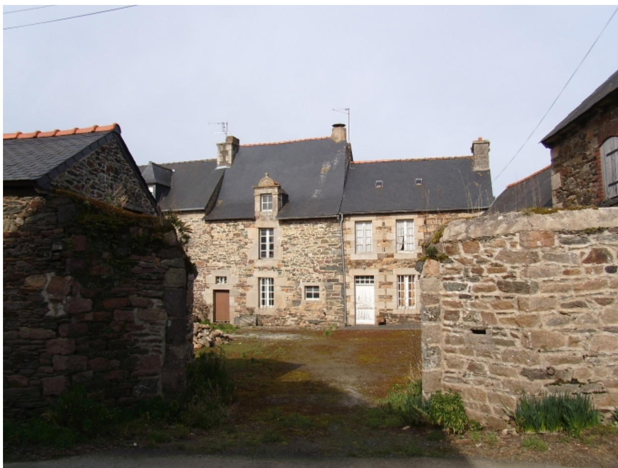
Logis de droite, élévations antérieures sur cour
