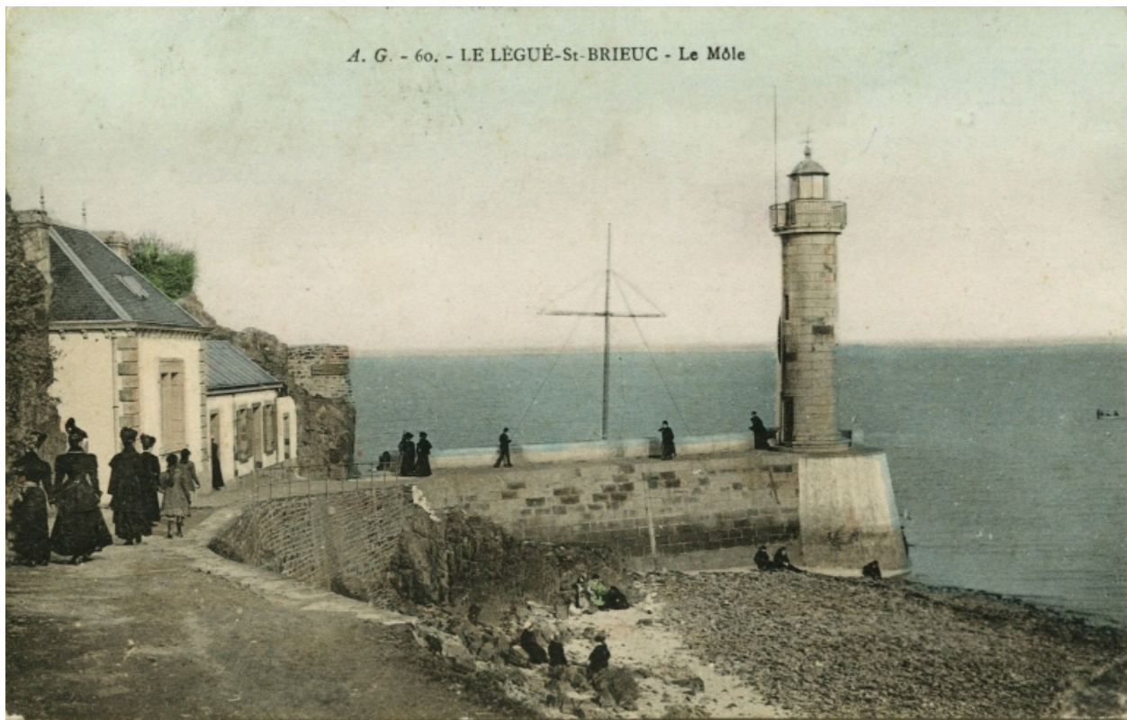
Vue du phare, de la digue, du mât sémaphorique et de la maison du gardien, en 1908 (carte postale, AD 22)
