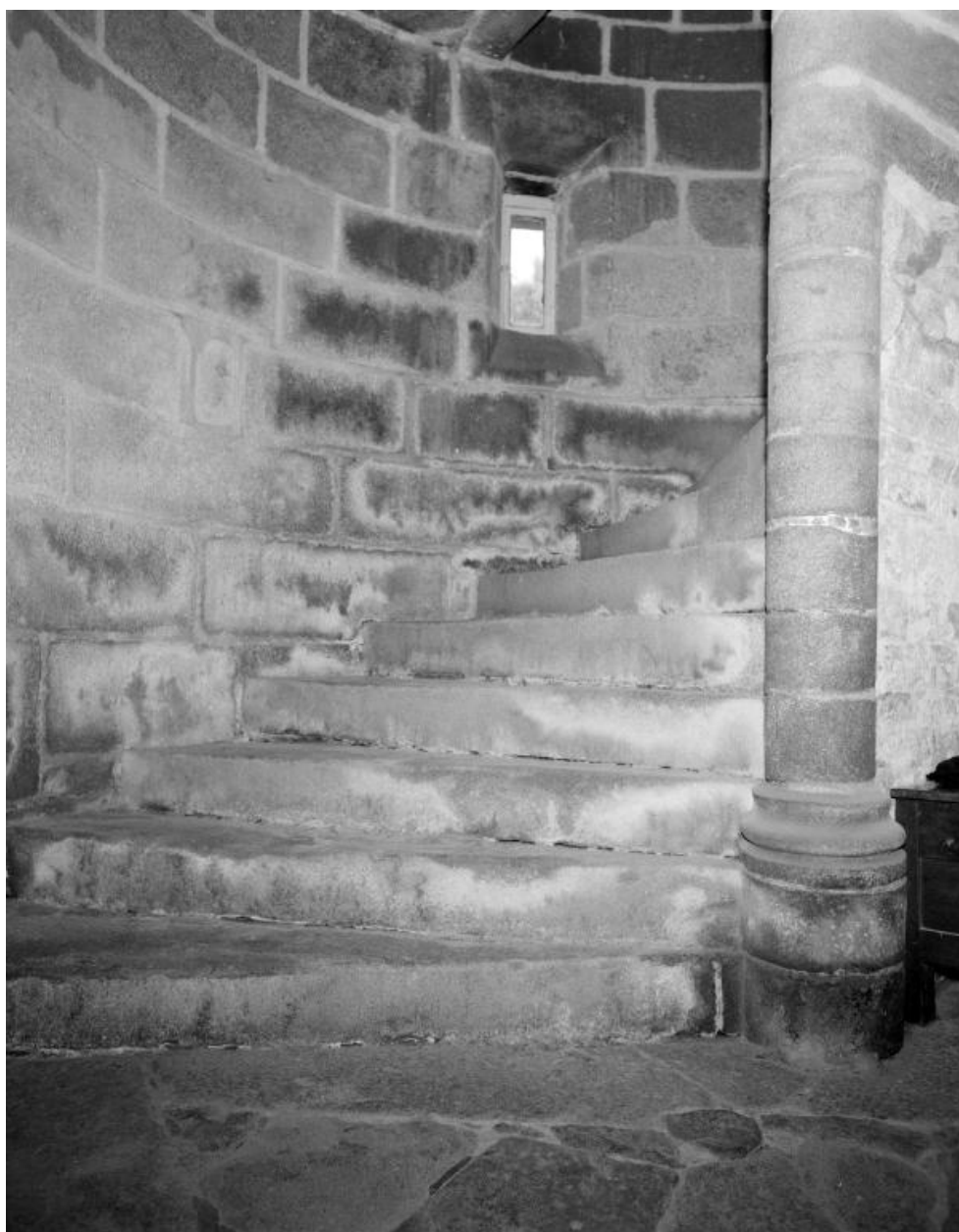
Intérieur, escalier de pierre, vue générale
