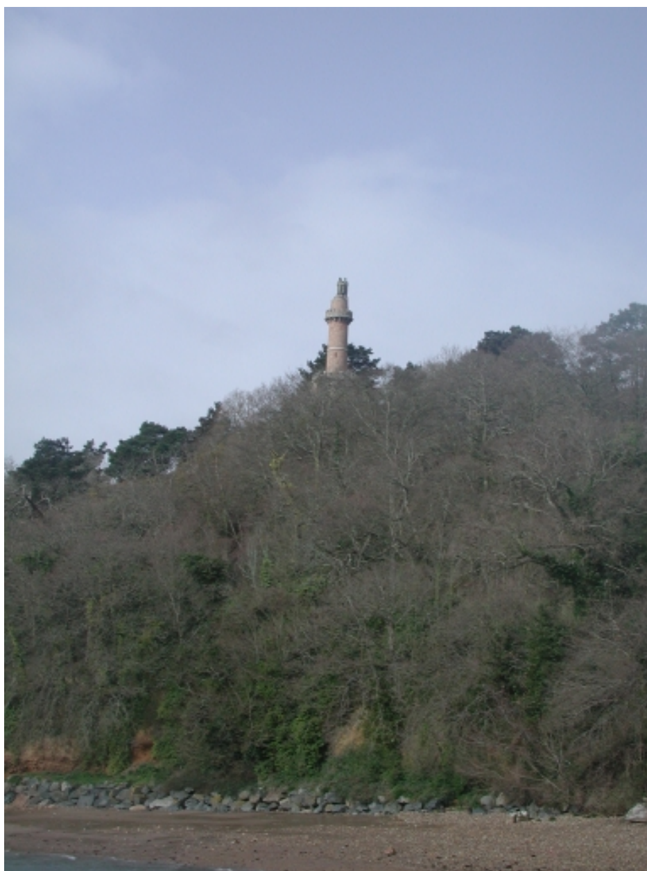
Enrochements sous la tour de Kerroc'h
