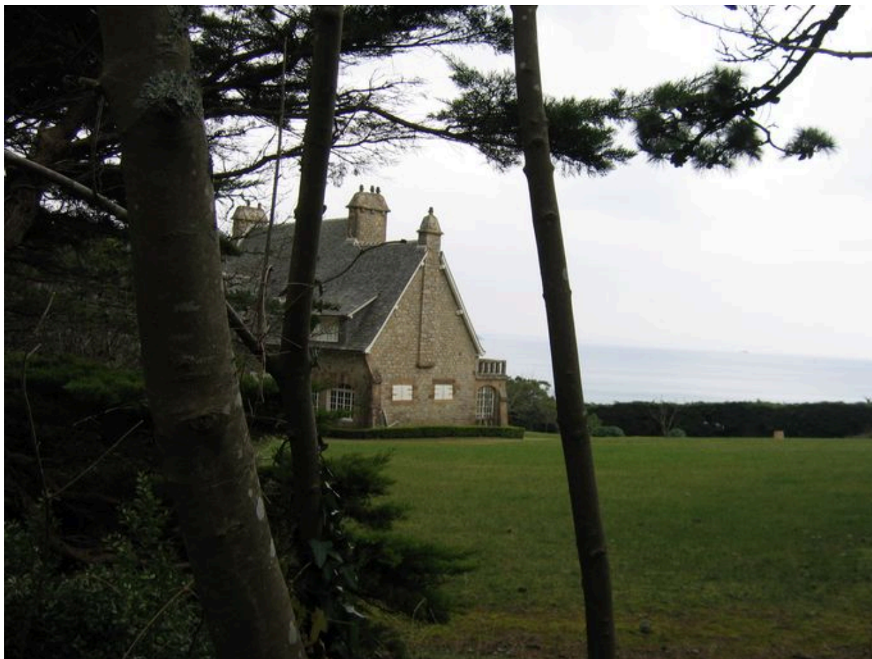
Vue latérale de la villa Les Grottes
