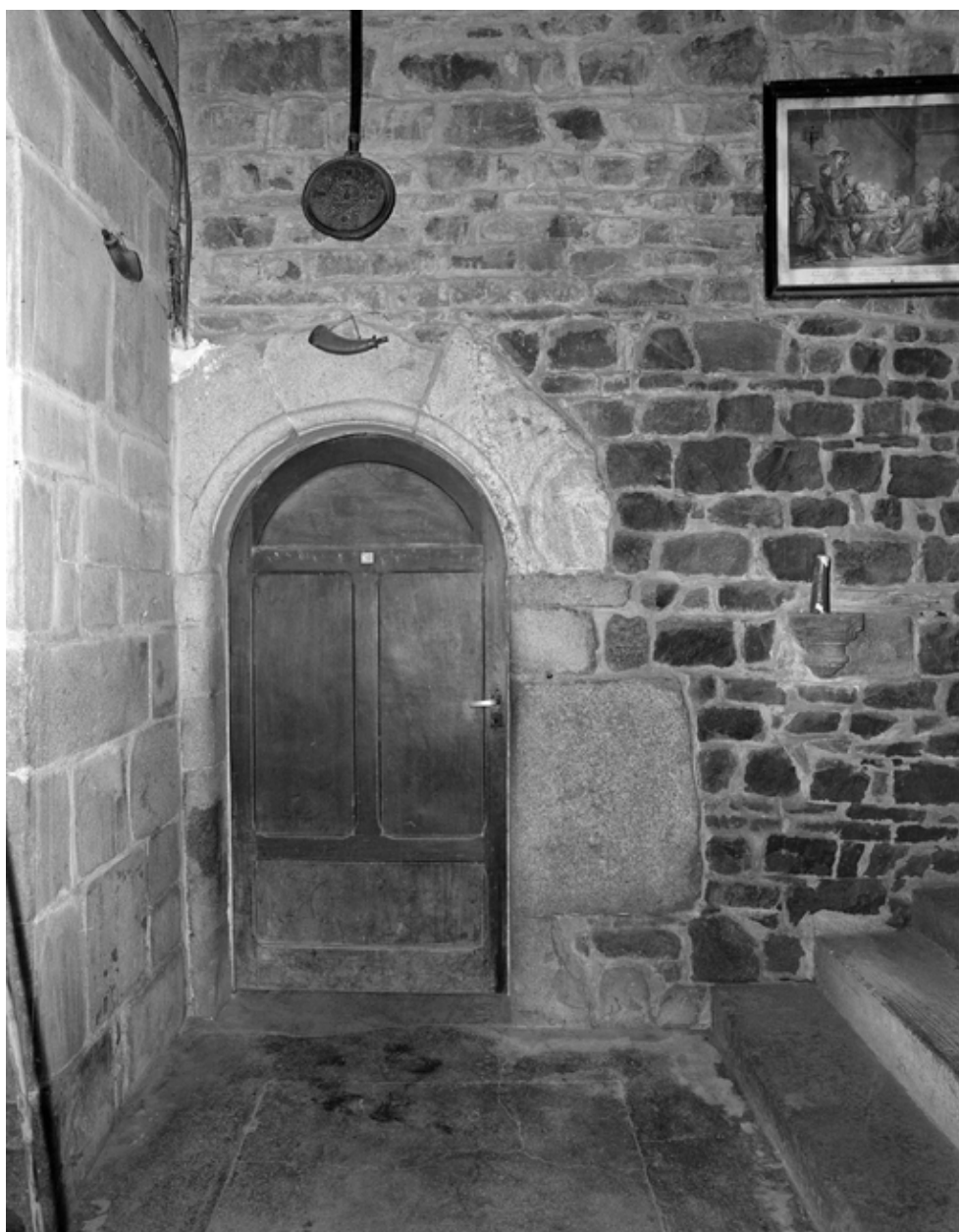
Porte à gauche de l'escalier
