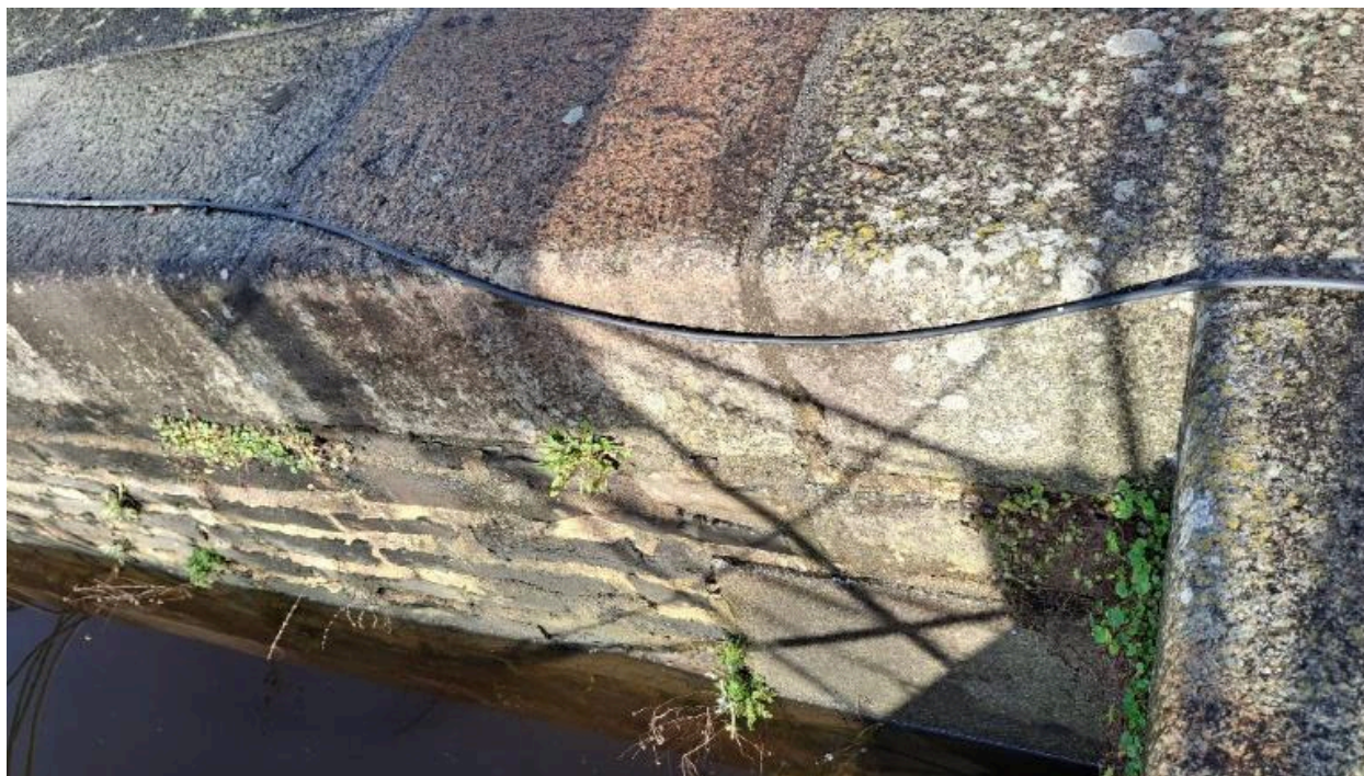
Maçonnerie des quais
