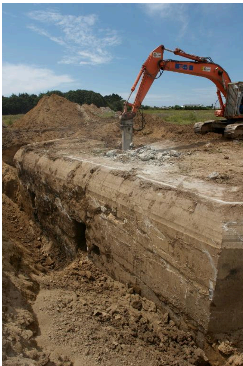
Déconstruction d'un bunker de type 502
