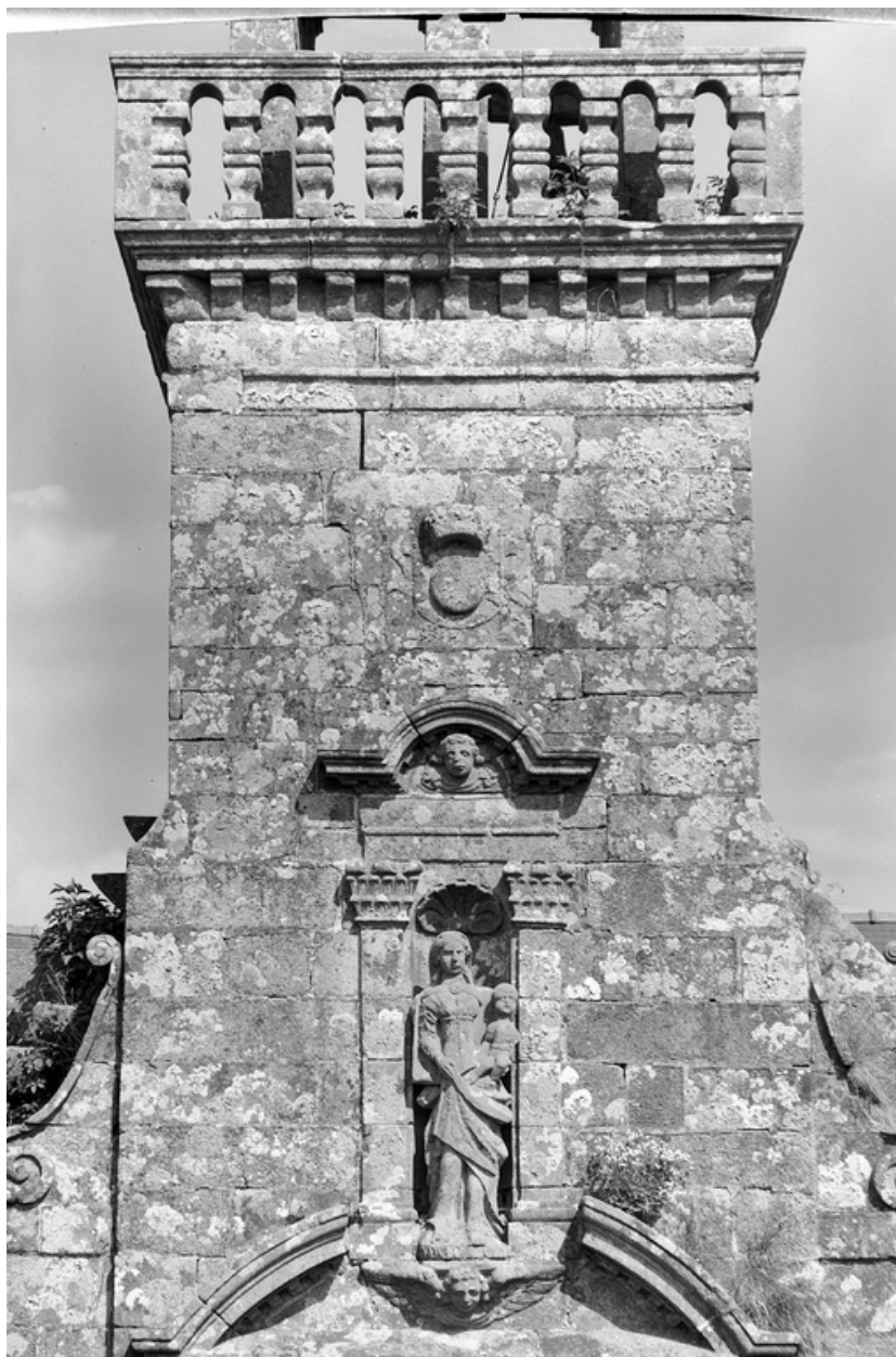
Tour du clocher, face ouest : vue générale du 2ème niveau
