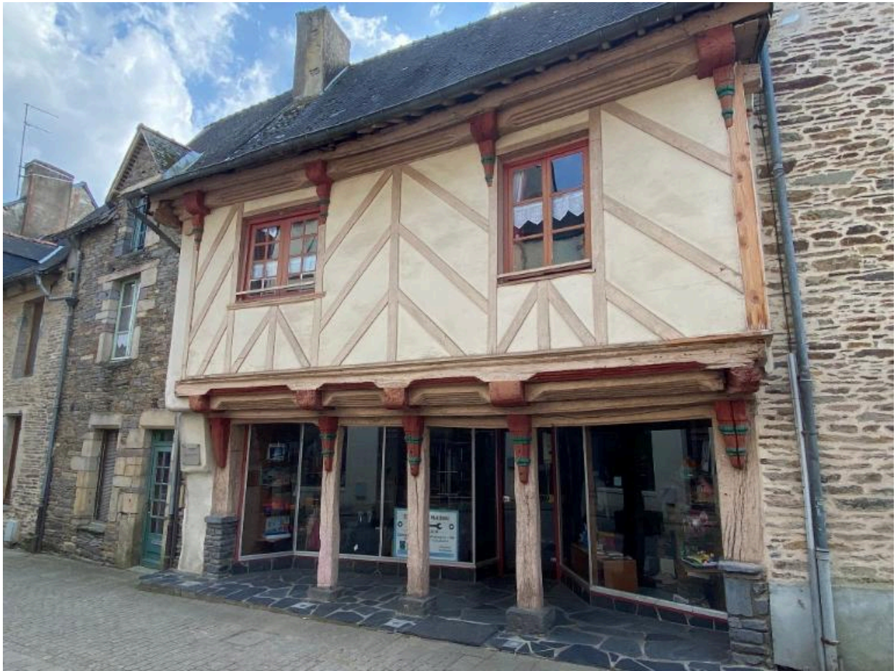
Élévation est, vue générale
