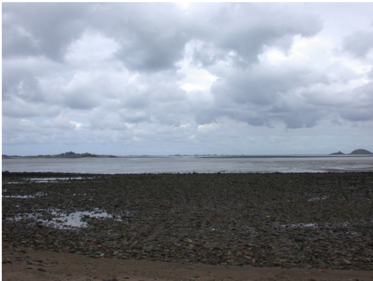
Vue des vestiges de la grande digue de Beauport à marée basse
