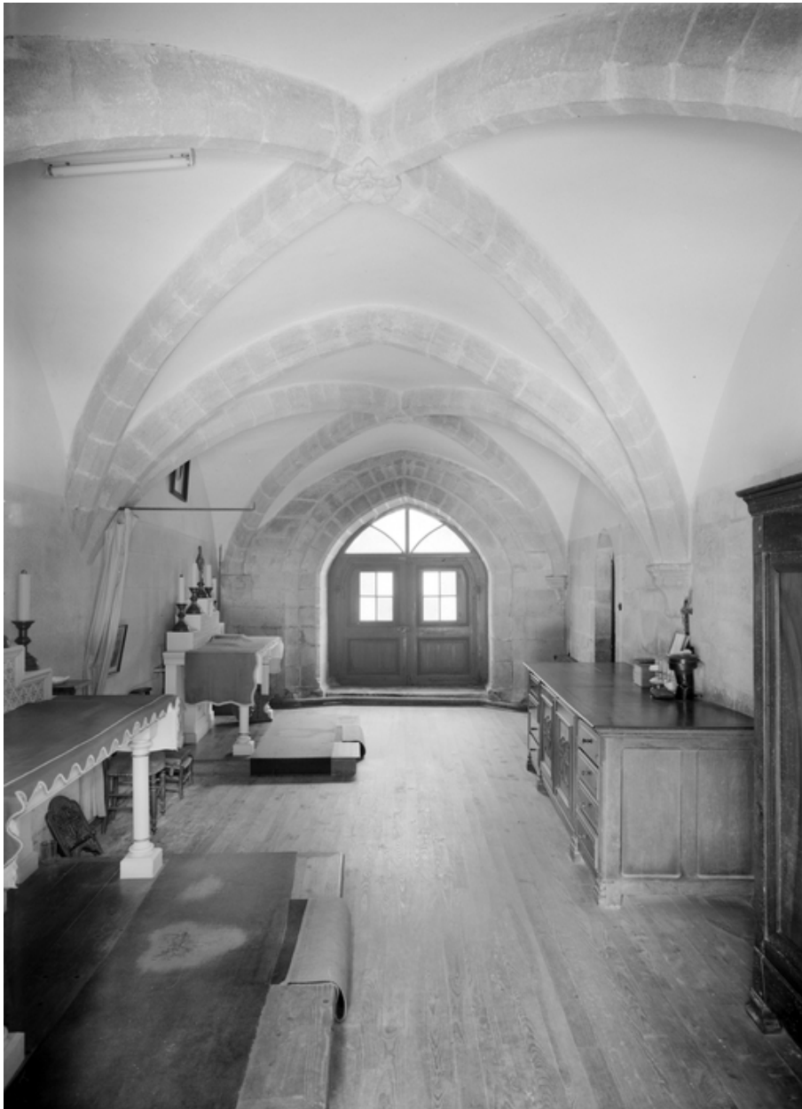
Corps de bâtiment D, pièce au nord de la salle capitulaire, prise de la porte du cloître (1965)
