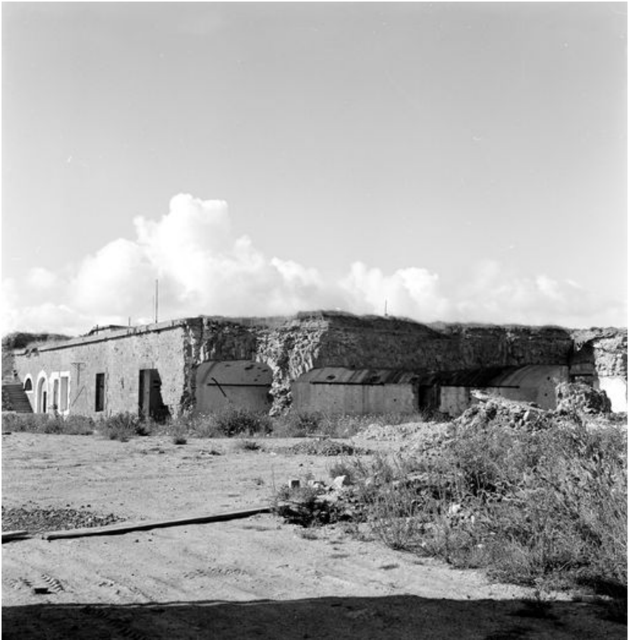
Vue du réduit de Quélern en 1969 : extrémité sud de la caserne casematée en partie détruite par les bombardements de 1944. Au premier plan : deux casemates éventrées
