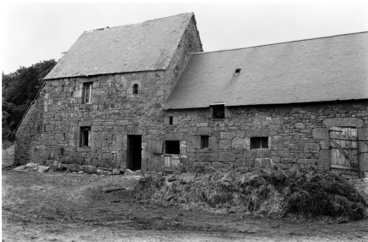
Maison (Kéravel) : vue de la façade sud
