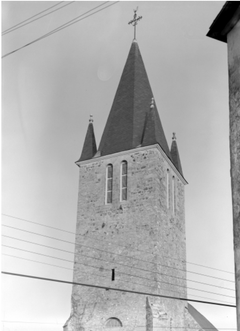
Elévation ouest, clocher, partie haute : vue générale
