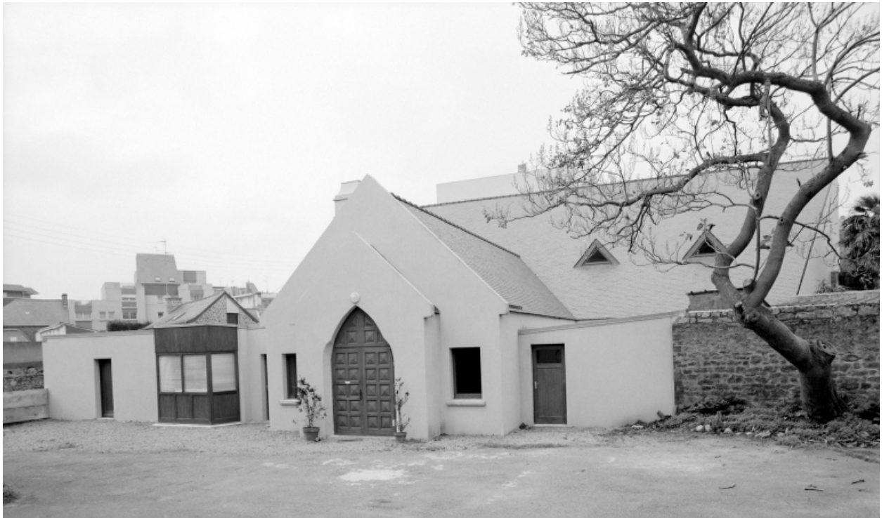
Elévation Est : vue générale
