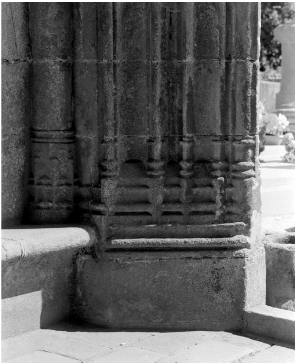
Intérieur du porche : ébrasement de l'angle sud est
