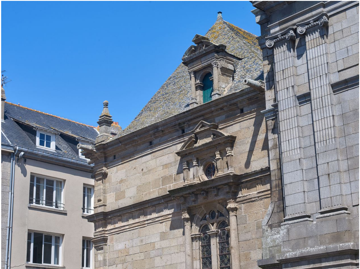
Partie supérieure au dessus du portail ouest, détail d'une travée
