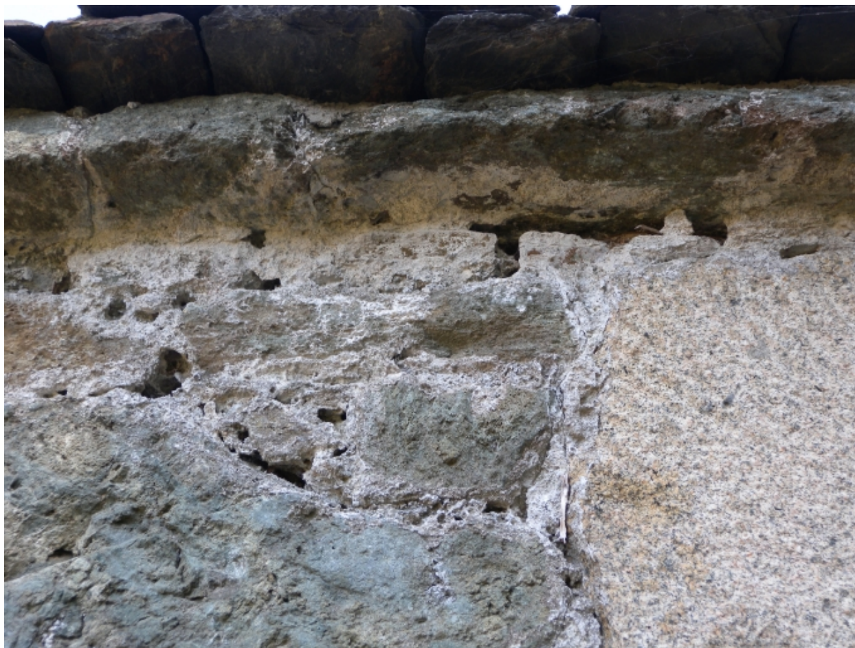
Vue de la couverture en lauze
