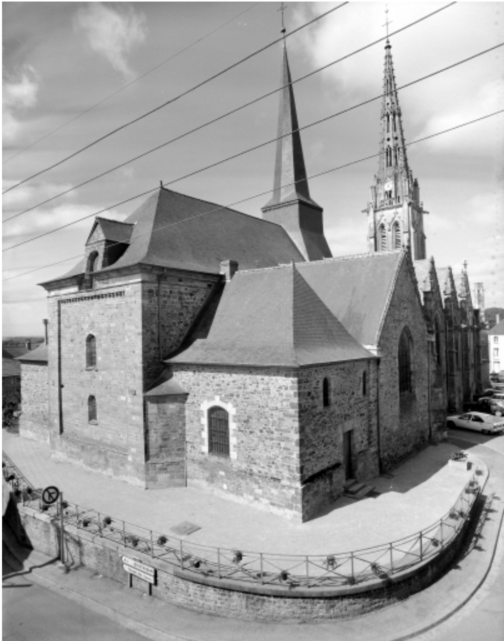
Elévation Nord-Est : vue générale
