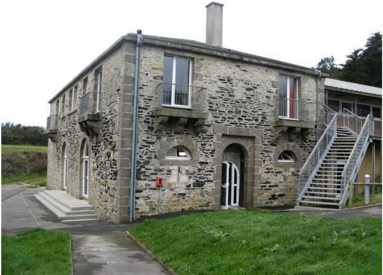
Vue générale du fort de Postolonnec
