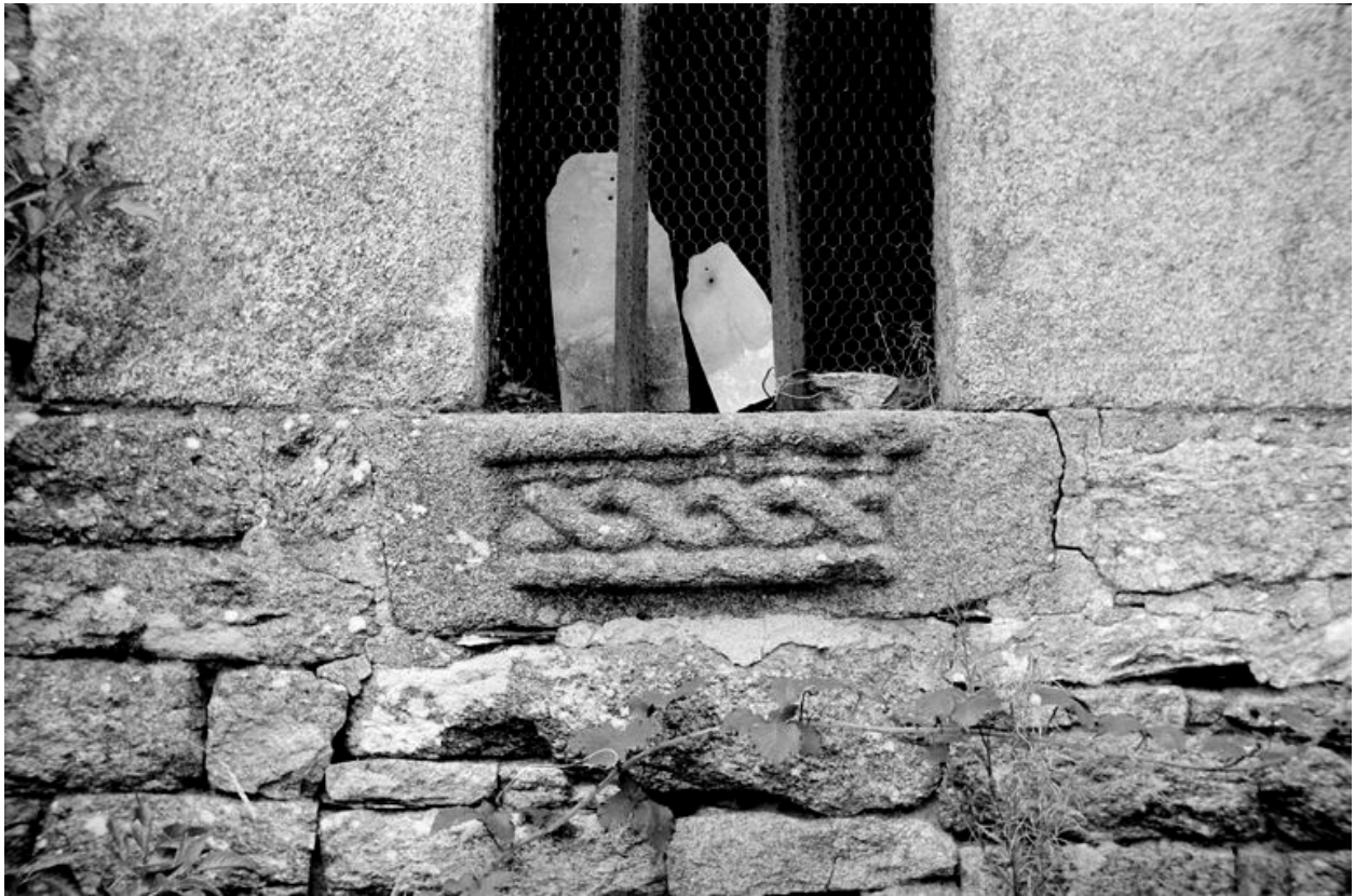
La Touche Bourdo, ferme du 16e siècle ? : un appui de fenêtre (état en 1969)
