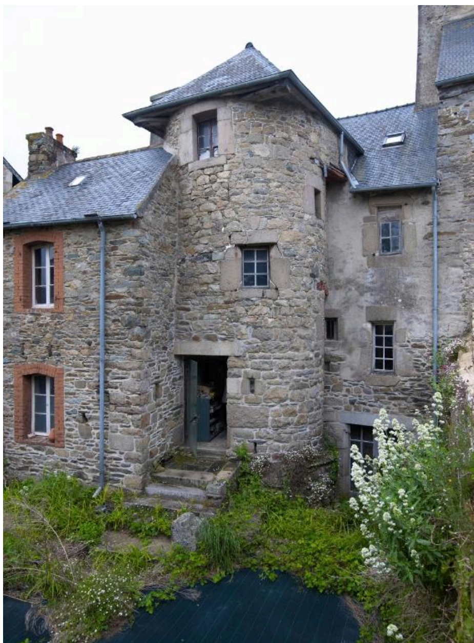
Façade arrière. Vue générale sud
