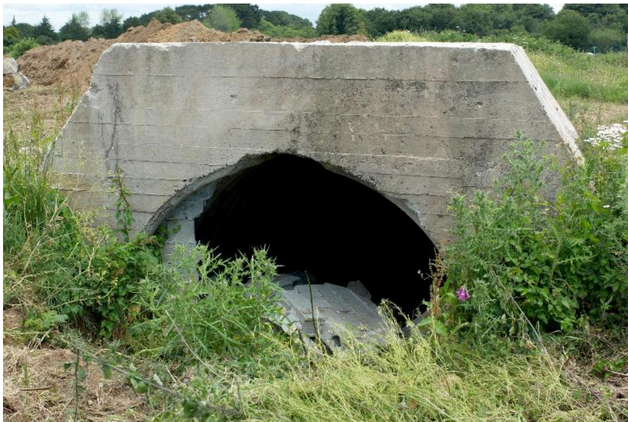
Bunker de type tôle métro (Heinrich Wellblech)
