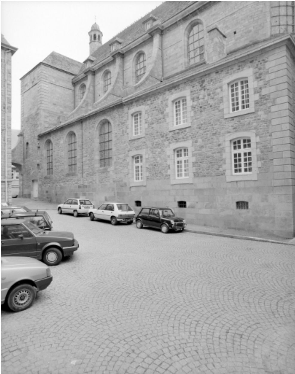
Elévation Ouest : vue générale
