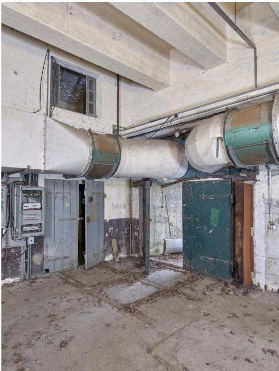
Locaux techniques, partie nord, rez-de-chaussée, grande pièce de la centrale électrique : gaines de ventilation implantées au-dessus de la porte (en bois, doublé de métal). La fenêtre haute correspond à une pièce en entresol. A gauche, tableau électrique
