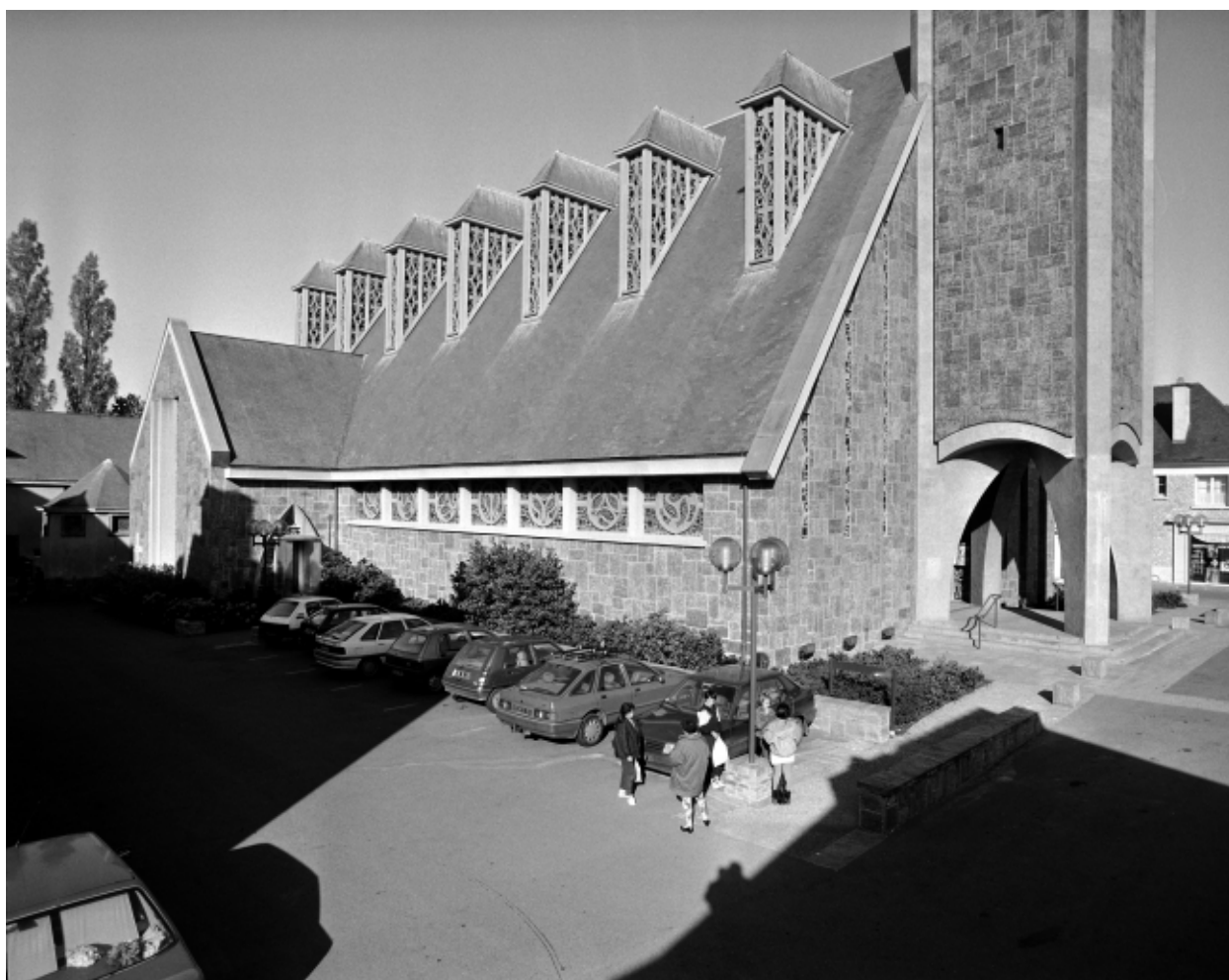
Elévation Sud : vue générale
