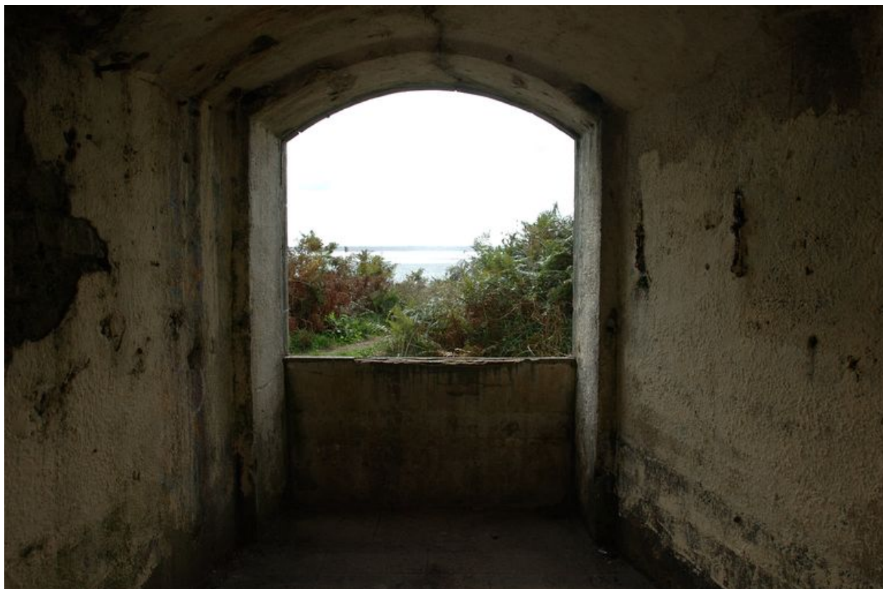
Vue des casemates de projecteur (état en 2007)
