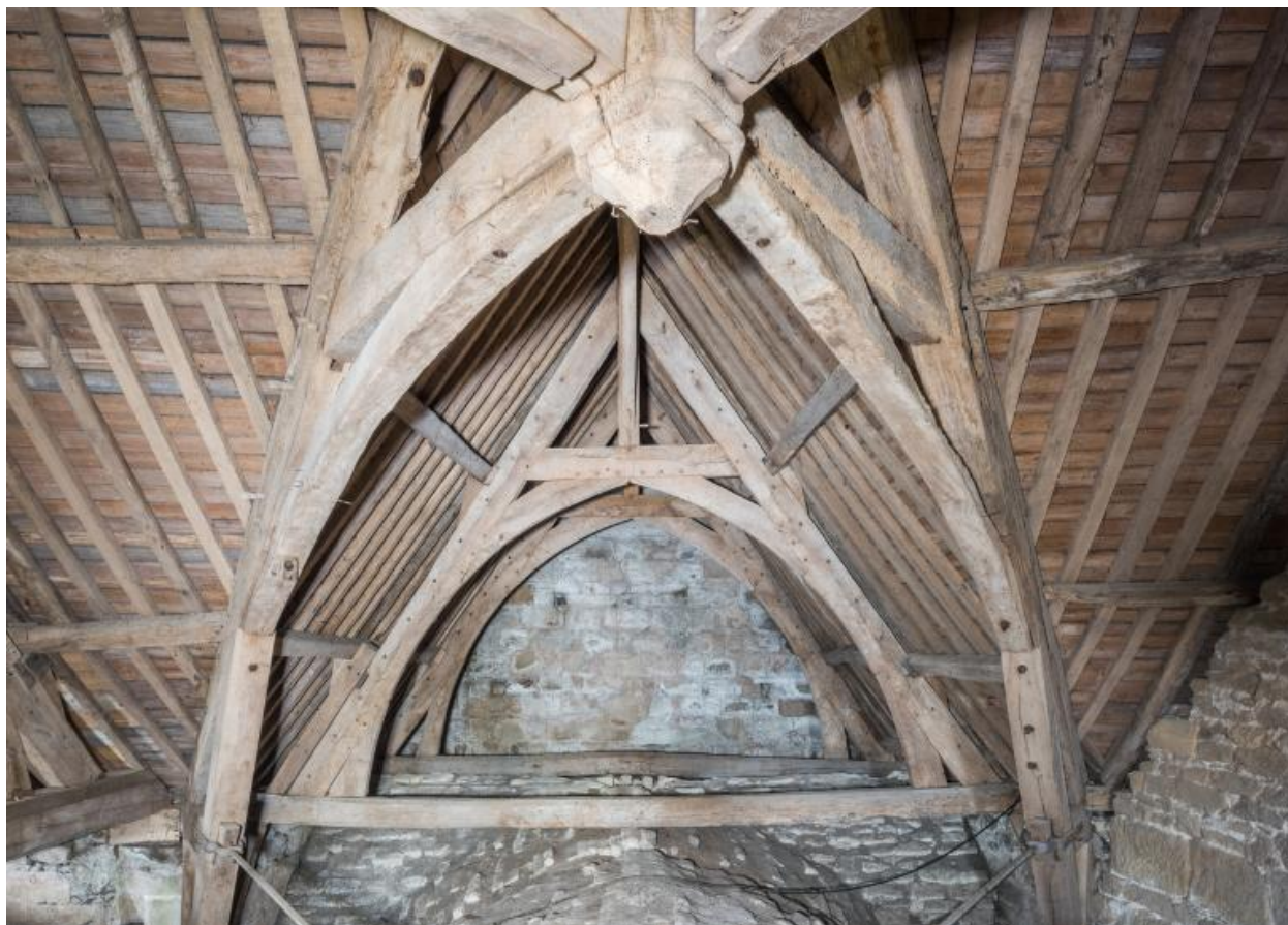
Vue de la clef de voûte de la charpente à la croisée du transept et de la charpente du bras sud du transept.
