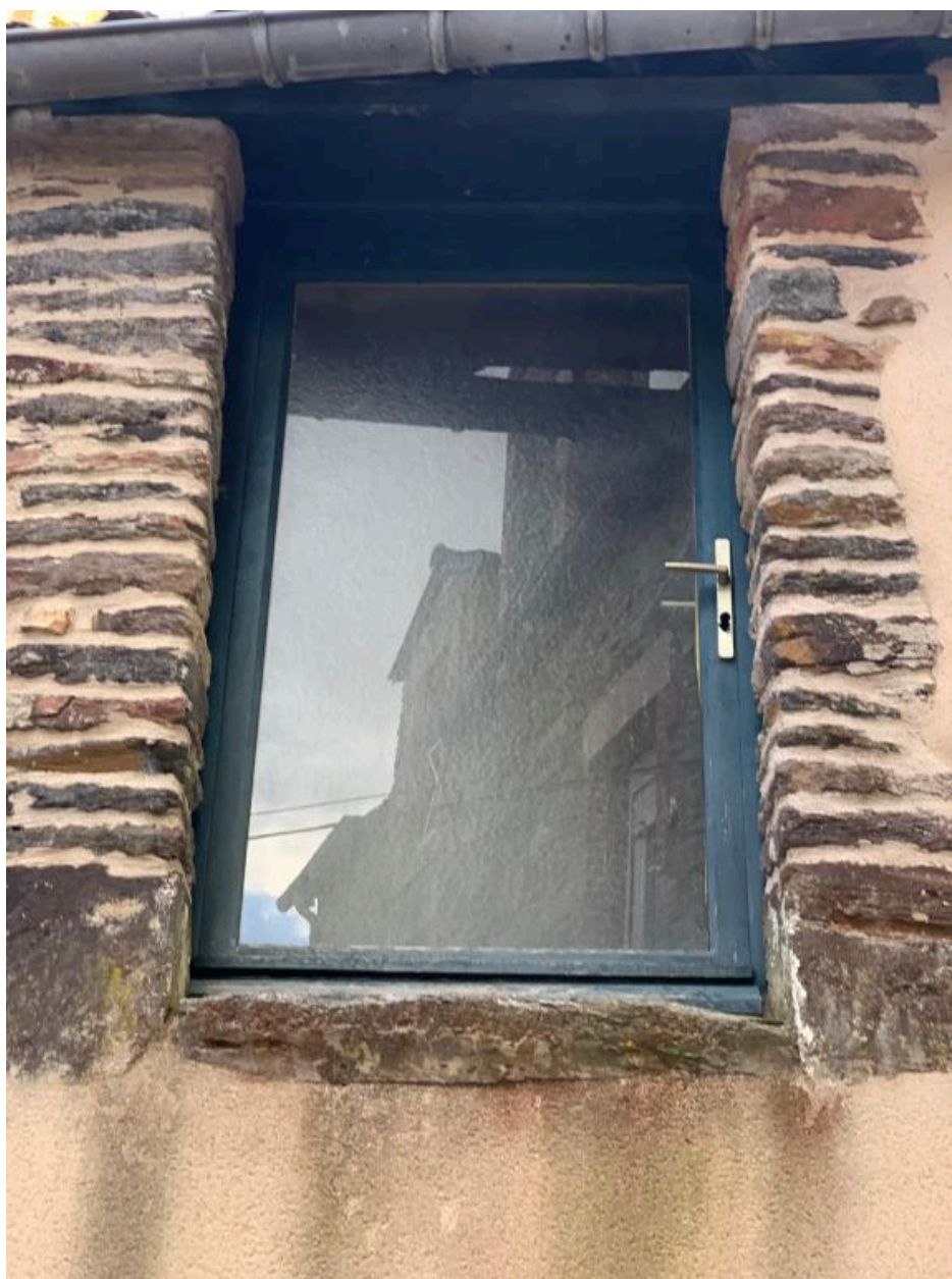
Elévation ouest, partie nord, fenêtre au premier étage
