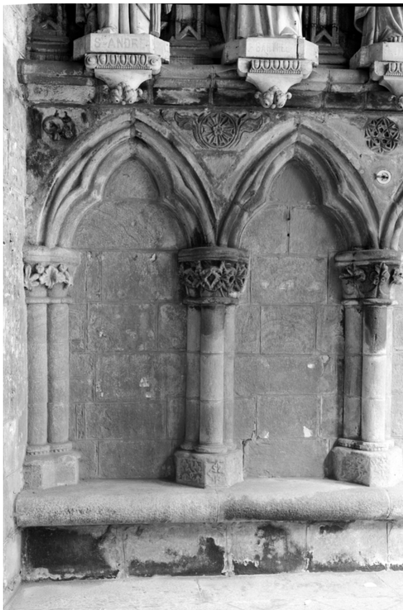
Porche sud, intérieur : mur est, détail des arcades 4 et 5 au sud
