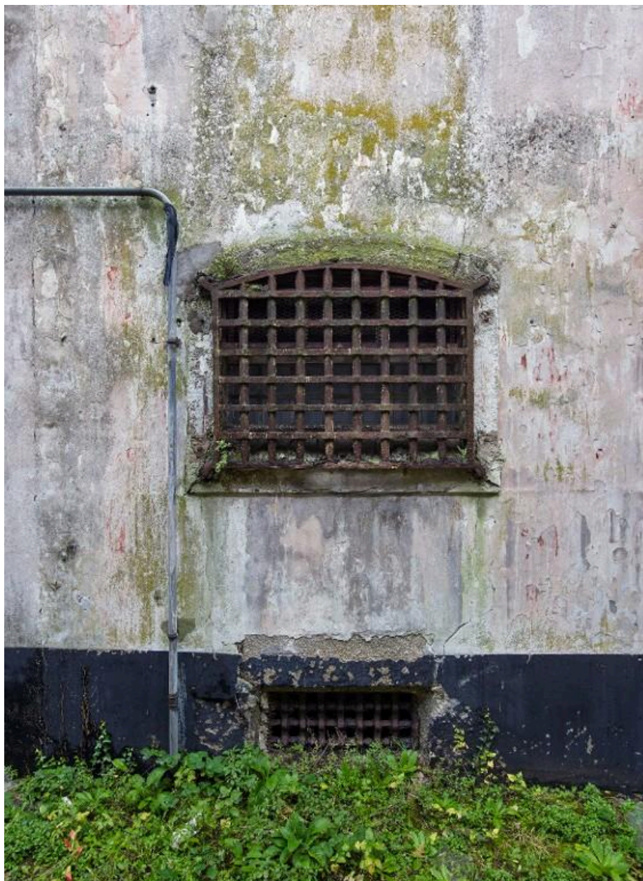
Vue de détail de l'élévation ouest du bâtiment carcéral : baie avec grille donnant sur la cour. Le mur conserve son enduit et sa bande de propreté peinte en noir
