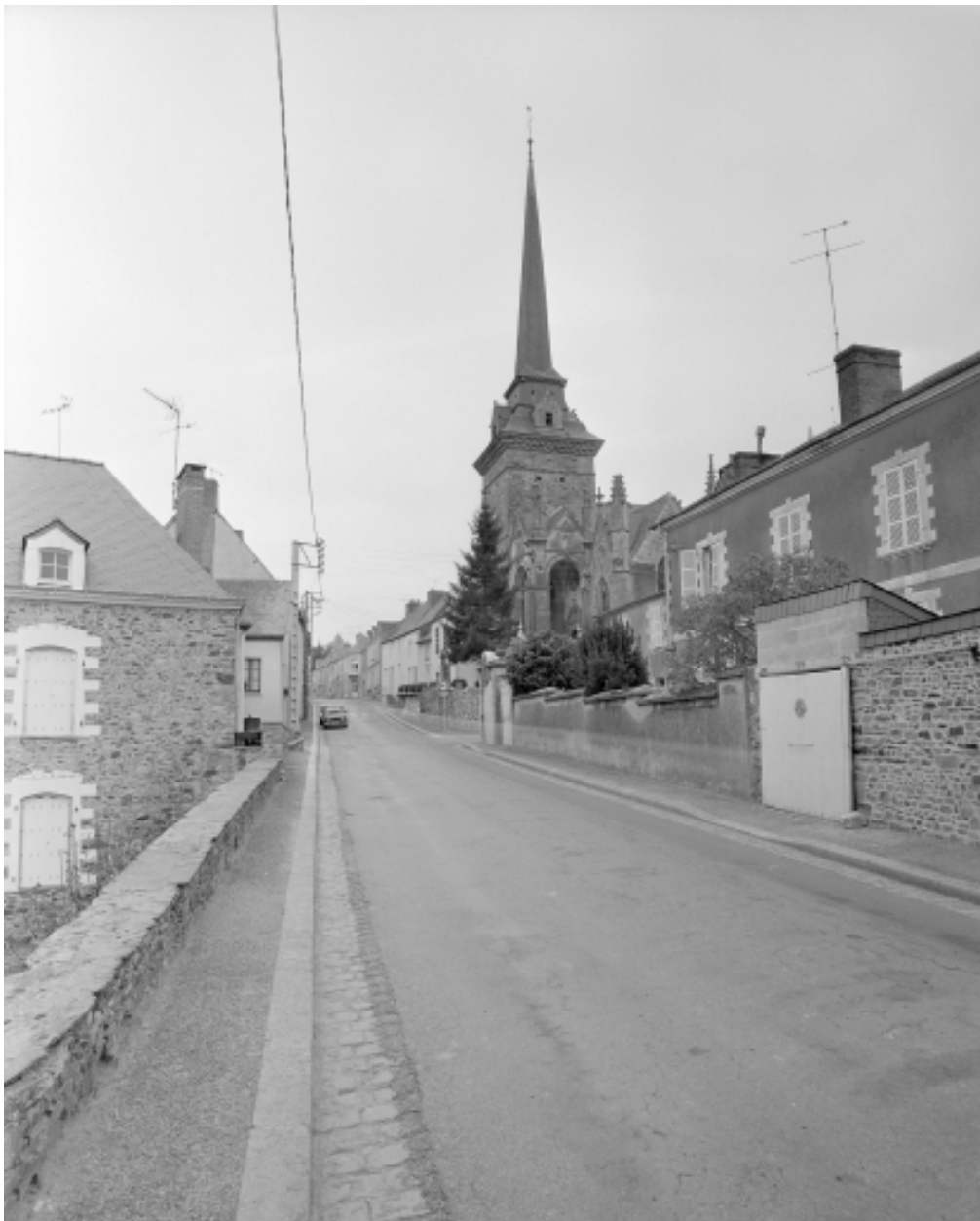
Elévation sud ouest, clocher : vue générale
