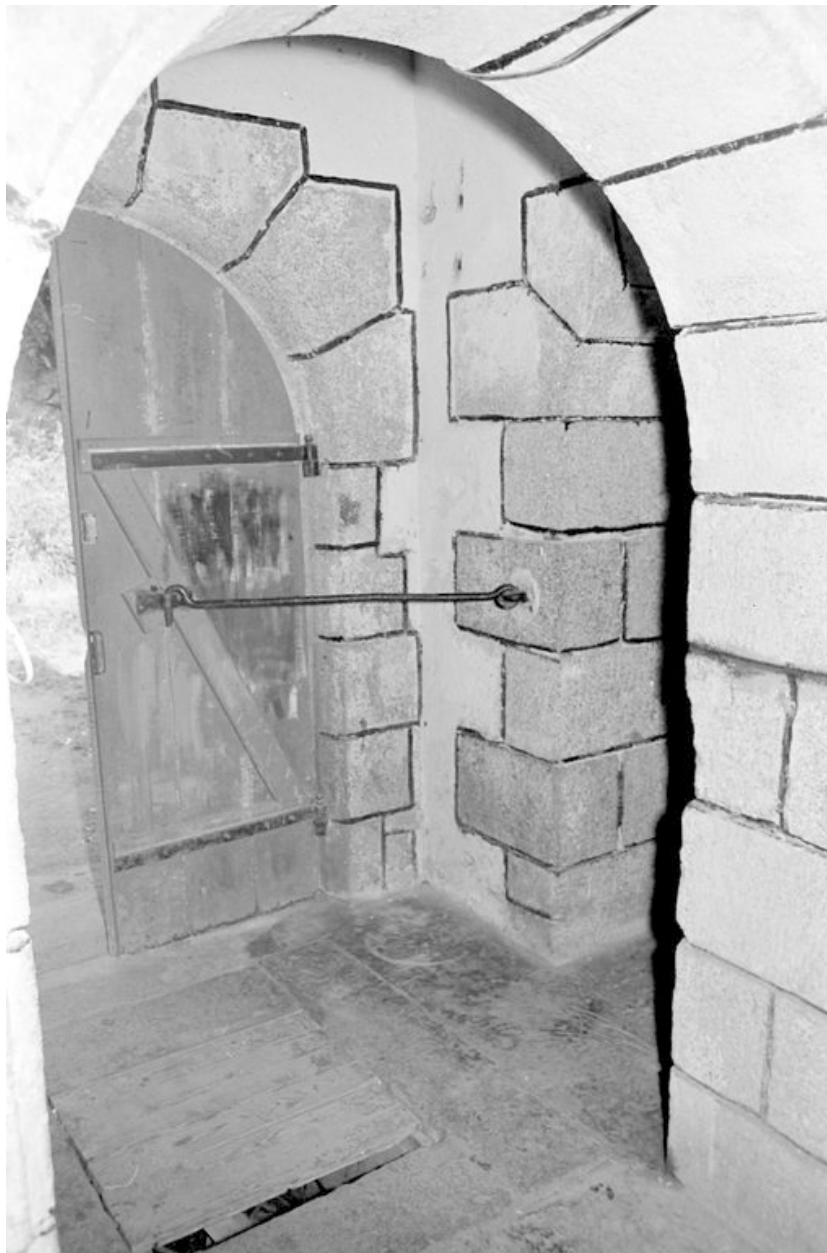
Vue du corps de garde crénelé n° 3 du bourg de Roscanvel en 1969 : intérieur, passage d'entrée
