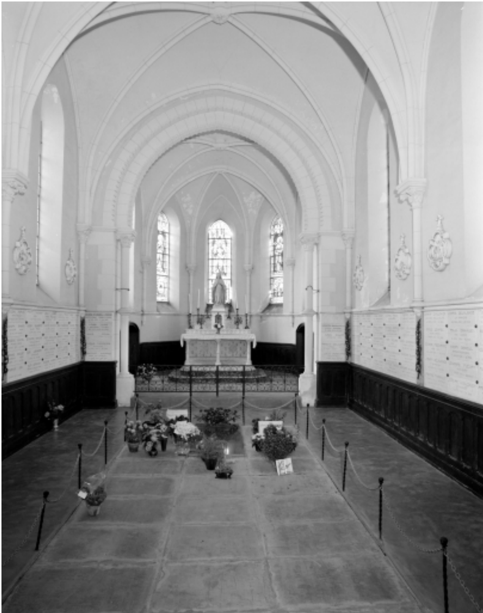
Intérieur : vue générale vers le chœur
