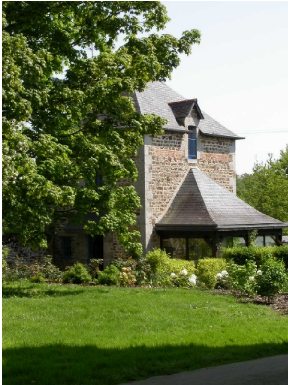
Bâtiment situé au nord-est du château
