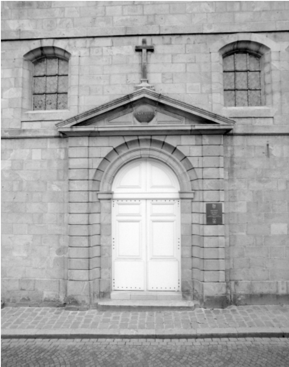
Elévation Nord, porte : vue générale
