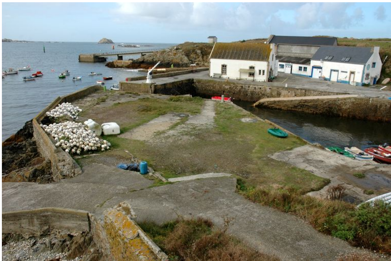
Vue du port-abri de Lampaul
