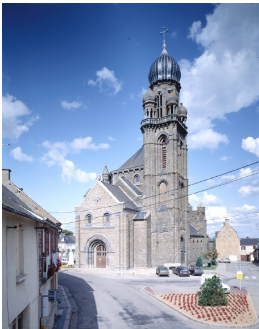
Elévation Ouest : vue générale
