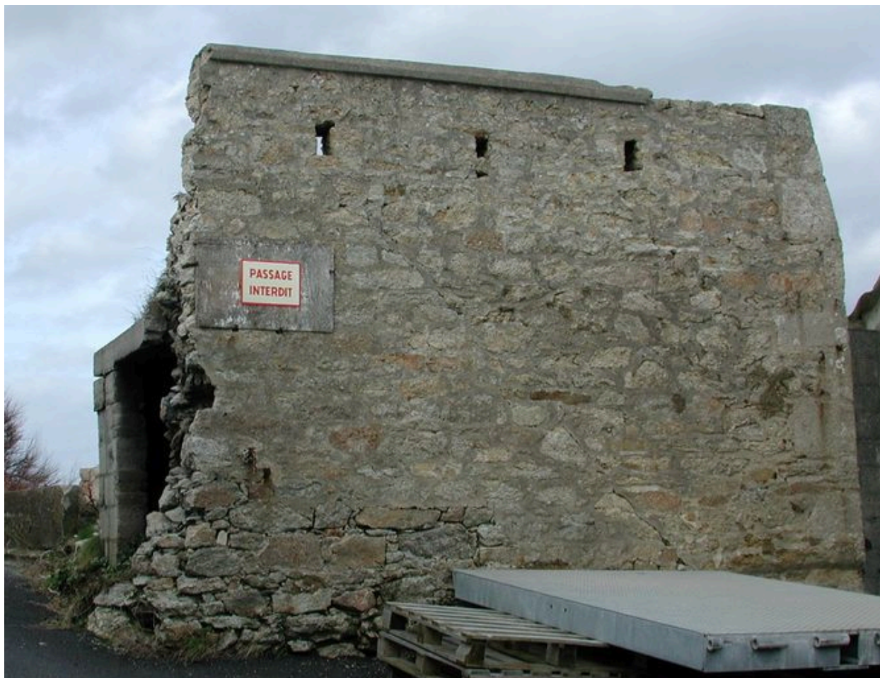
Vue générale depuis le sud (état en 2002)
