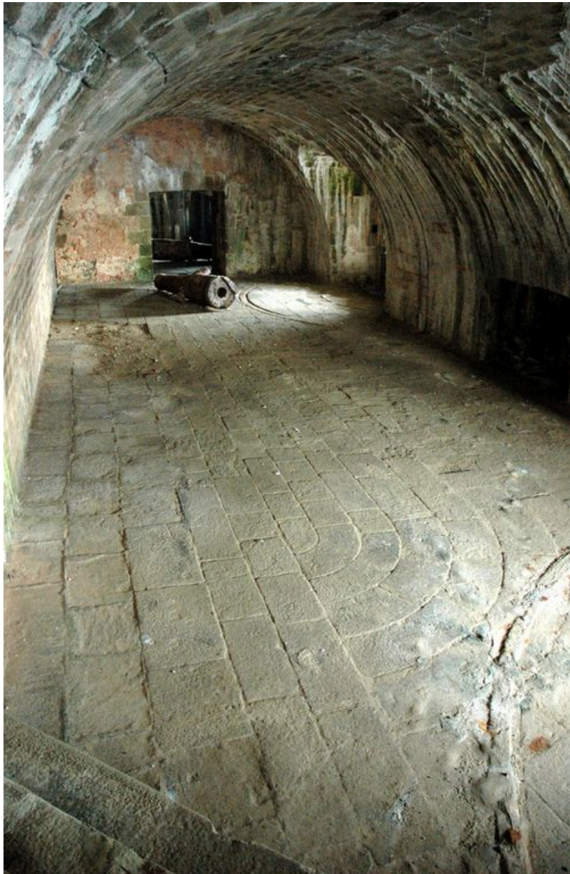
Vue du fort de la Conchée : casemate (n° 1) dit souterrain à deux embrasures. Tube de canon (b) à chargement par la culasse.
