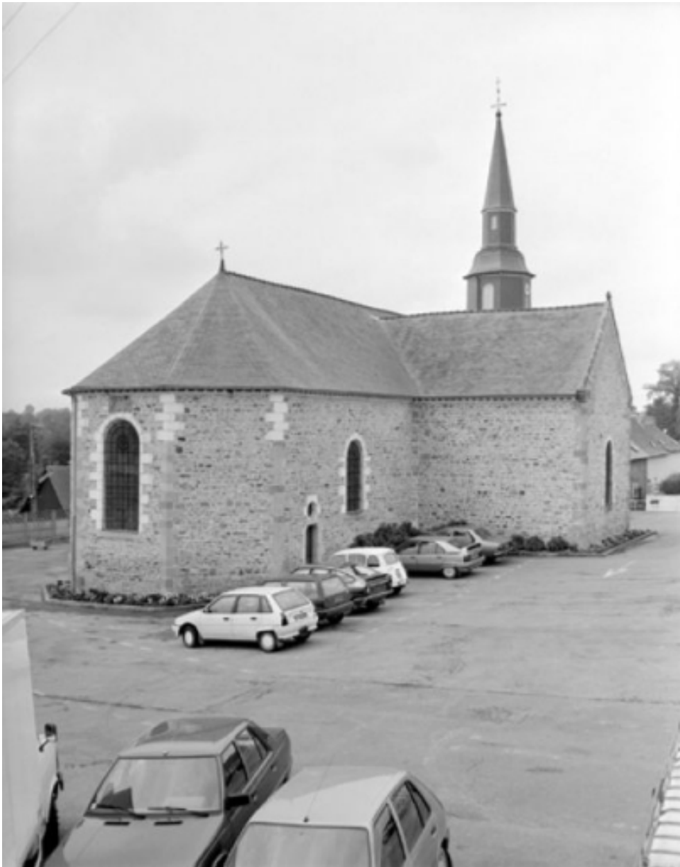
Élévation Nord-Est : vue générale
