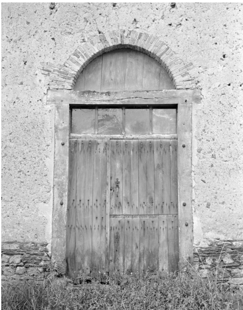
Vue de détail d'une porte de l'étable à côté du château.
