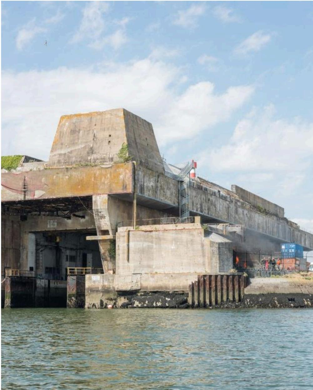
Vue de l'angle sud-est et entrée de l'alvéole G (sud). Cet angle de la base est protégé par une casemate pour canon et mitrailleuse et surmonté par un encuvement pour canon antiaérien
