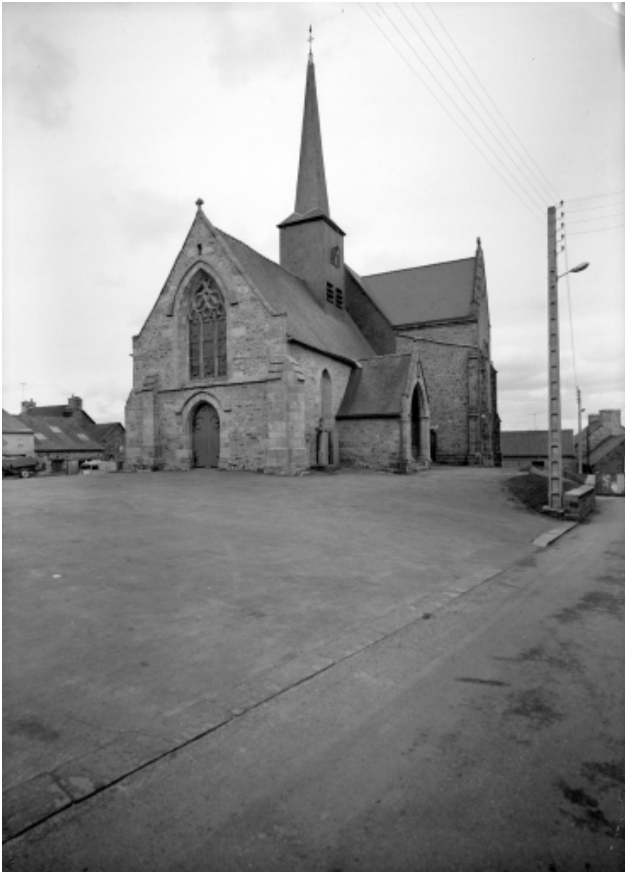
Elévation Sud-Ouest : vue générale
