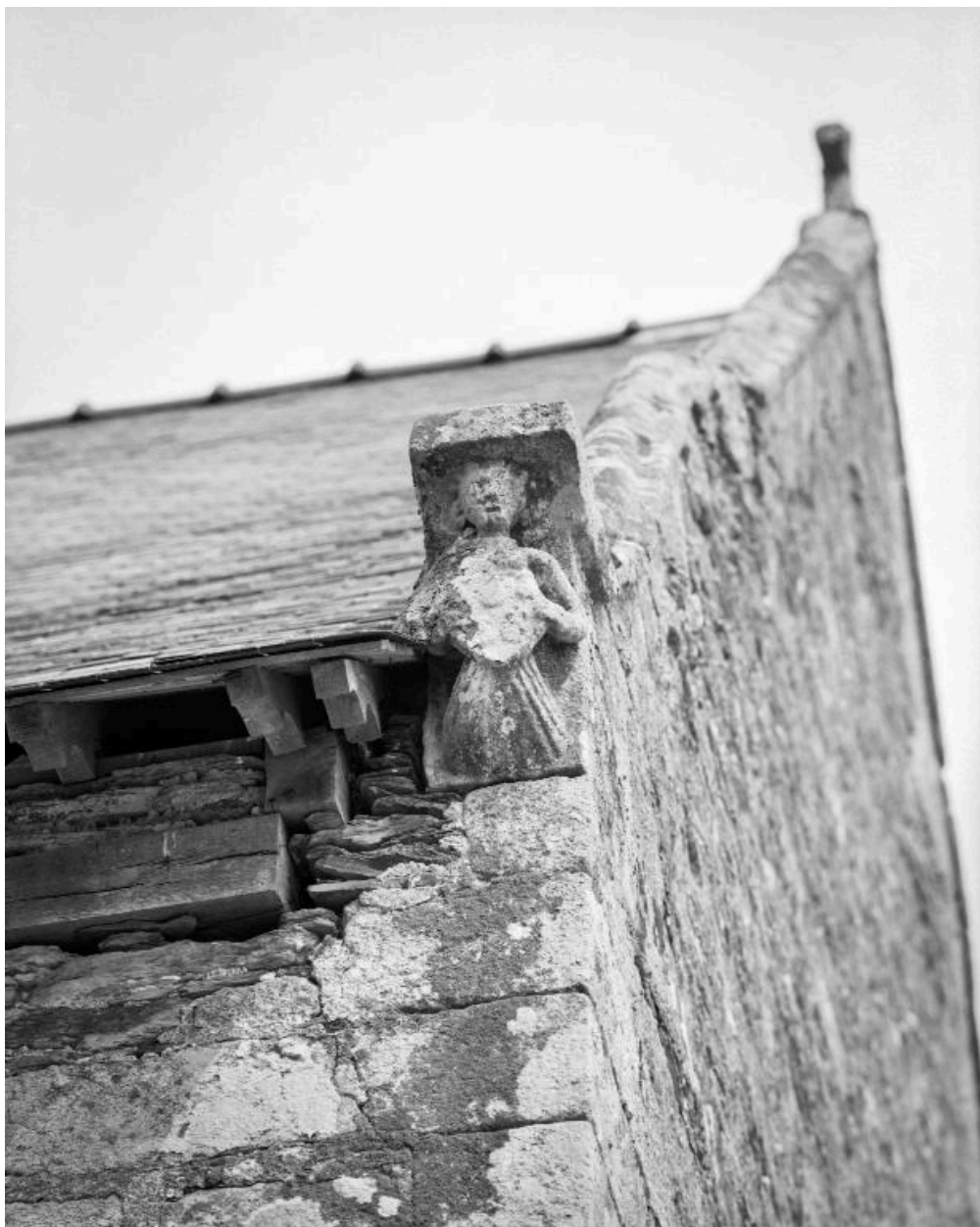
Chapelle, sur le rampant sud-est : crossette sculptée d'un ange portant des armoiries (état en 1984)
