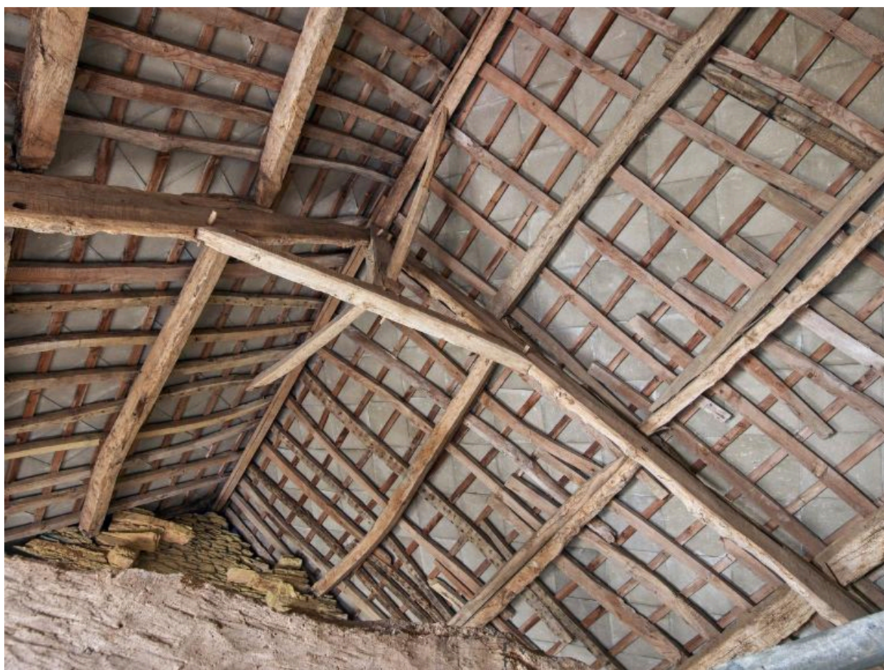
Logis 1706. Partie dépendance transformée en remise. Vue de la charpente
