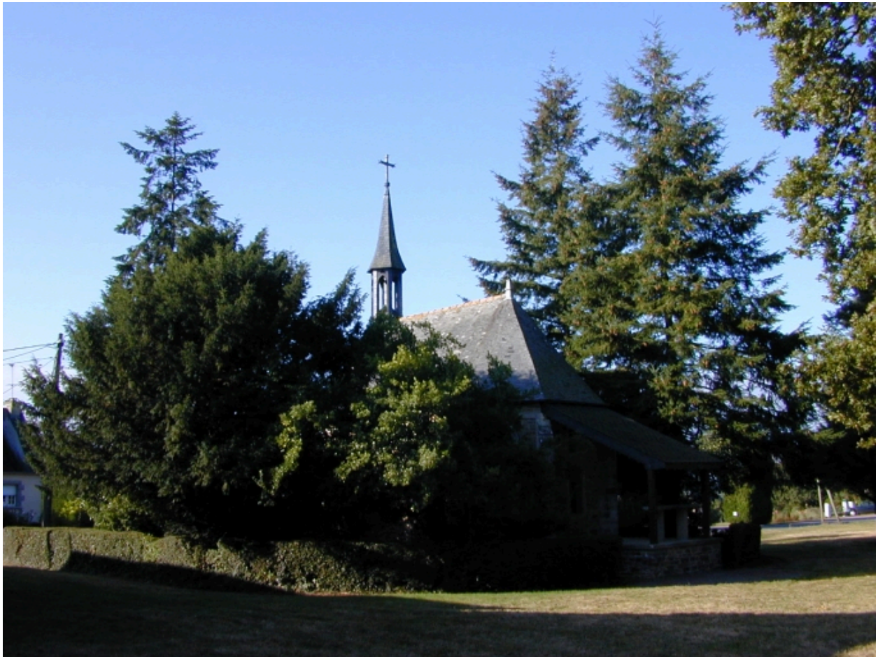
La longère est et le chevet : vue générale nord-est
